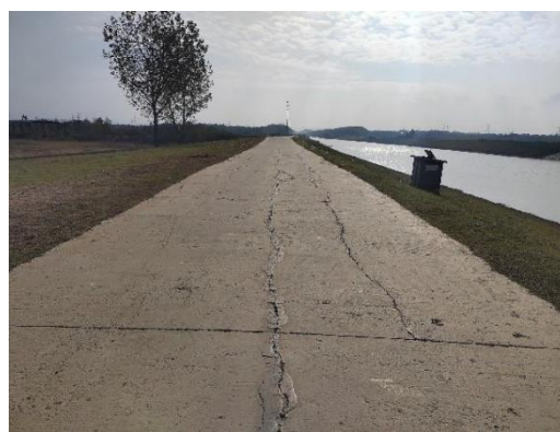
一干河常合高速桥上游右岸堤顶道路
