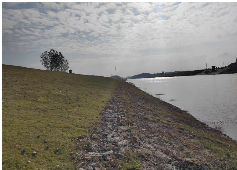
图 3.4-9 一干河已建雷诺护垫照片
