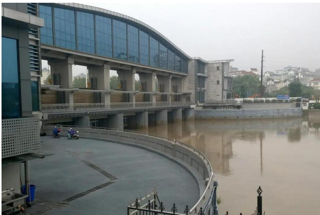
图 5.3-3 武定门水利枢纽工程
