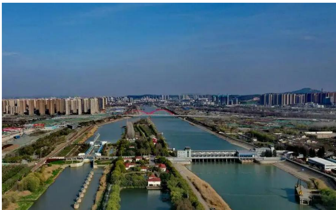
图 5.3-2 秦淮新河水利枢纽工程
