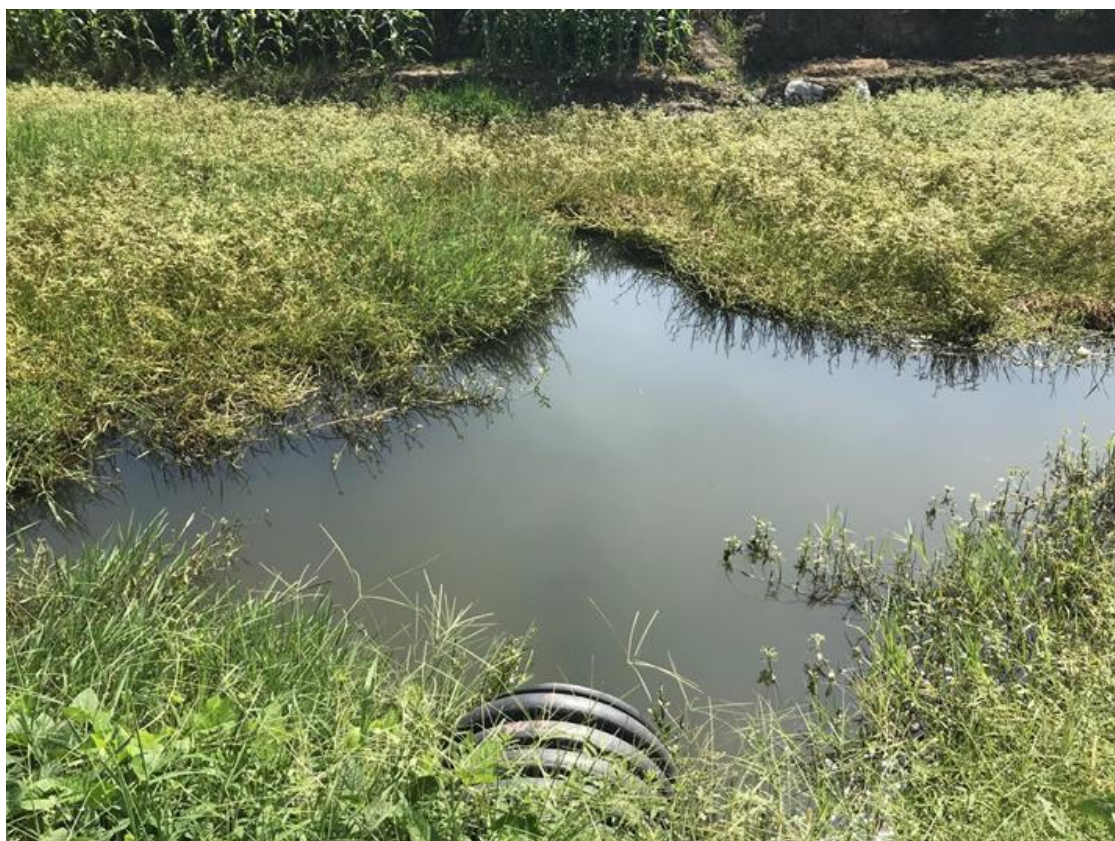
图 3.1.3-3 污水处理厂尾水排入长安河现场情况图
