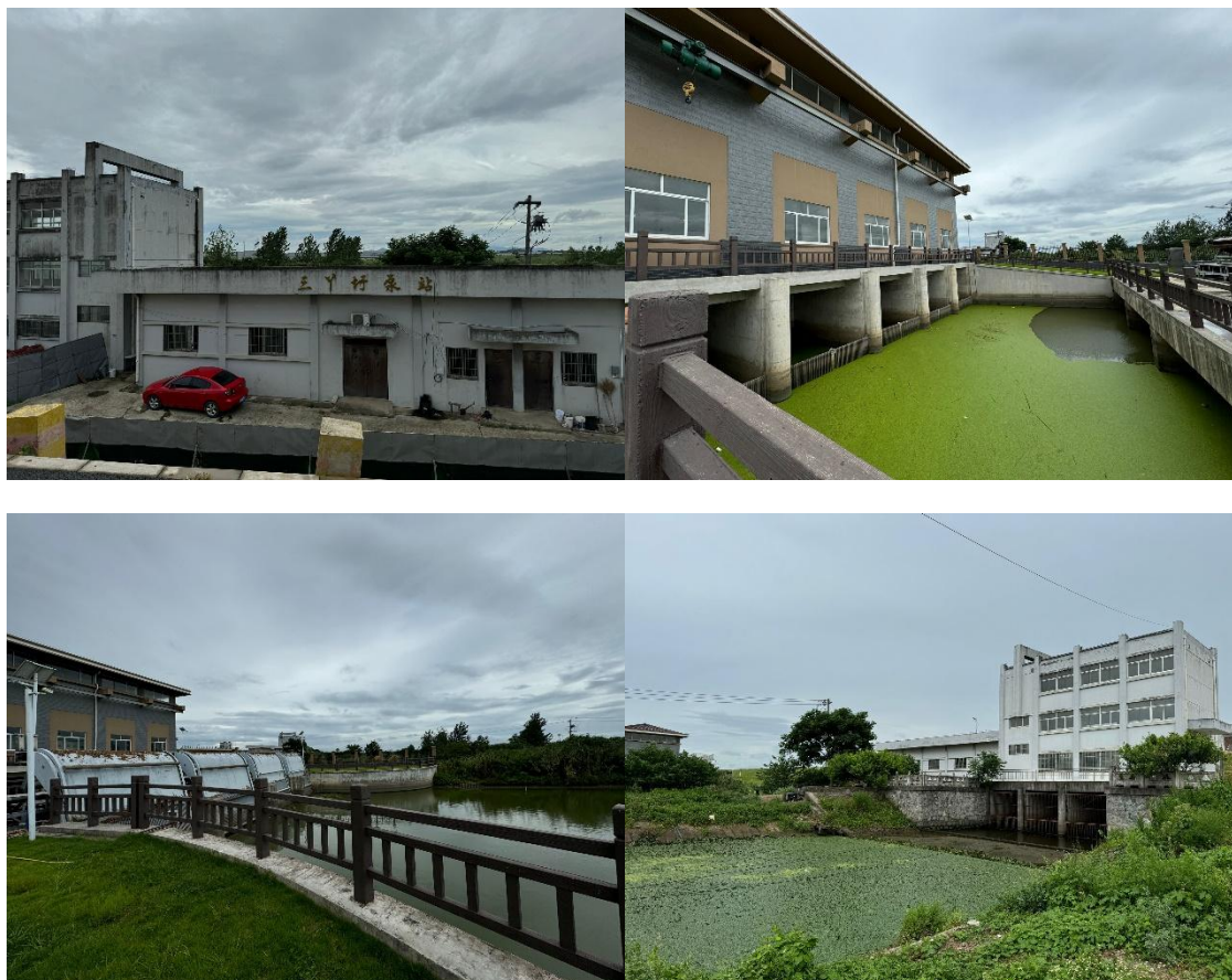
图 5.3-4 二干河三丫圩泵站现状图
