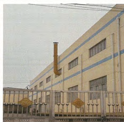
废气排口（DA001）
