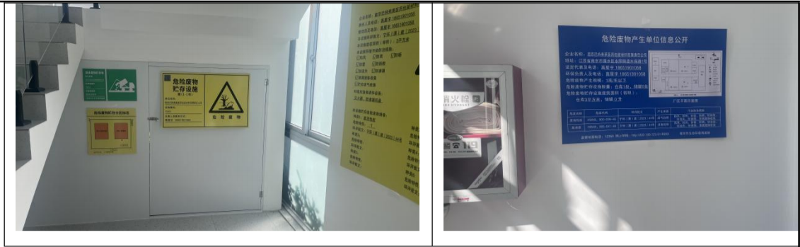
图 2-5 危废仓库外部
