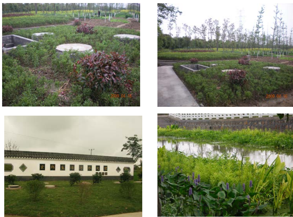
图5 A/O-人工湿地技术工程运行情况
